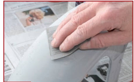
6. Grundierung anschleifen...
