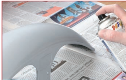
5. Grundierung auftragen...
